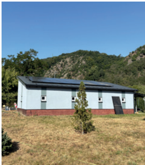
Fotovoltaika na budově ČOV
