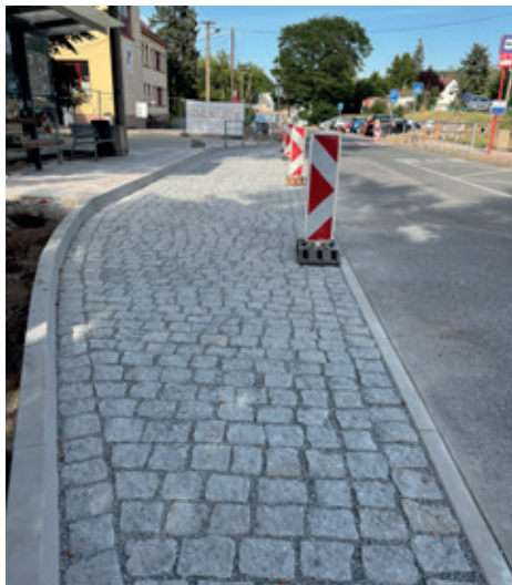
Výstavba autobusového zálivu u ZŠ
